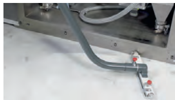
Le nettoyage des sols
