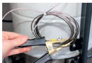
Liaison équipotentielle et mise à la terre
