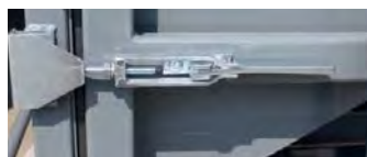
Crochet pour maintenir la fermeture de la porte
